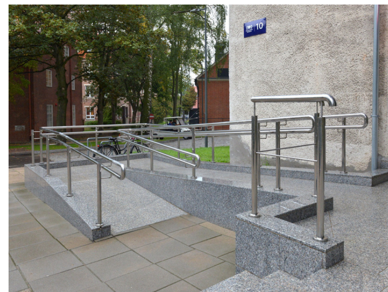
Podjazd dla osób z niepełnosprawnościami.
